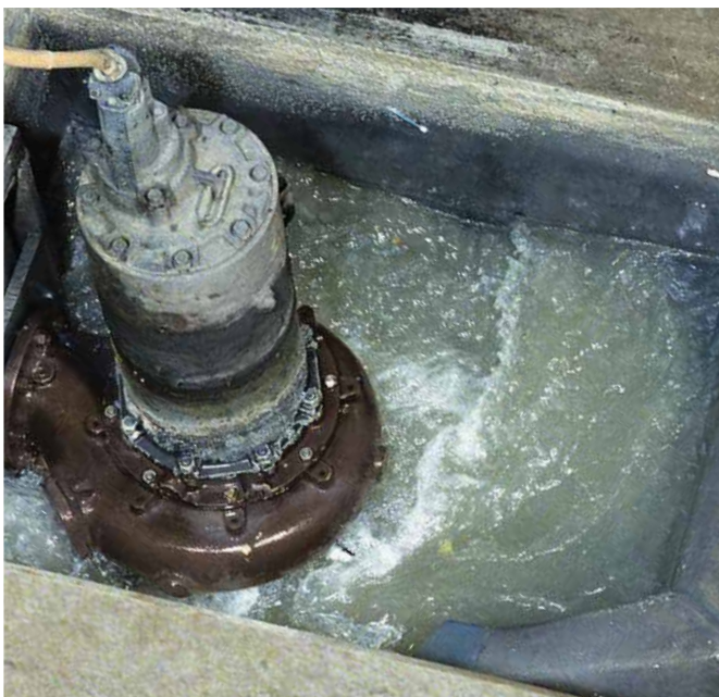
Schmutzwasserpumpe mit eigengekühltem Motor im Pumpensumpf
